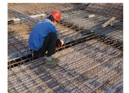
9. 现场附加钢筋绑扎
