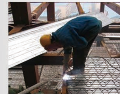
5. 竖向支座钢筋电焊
